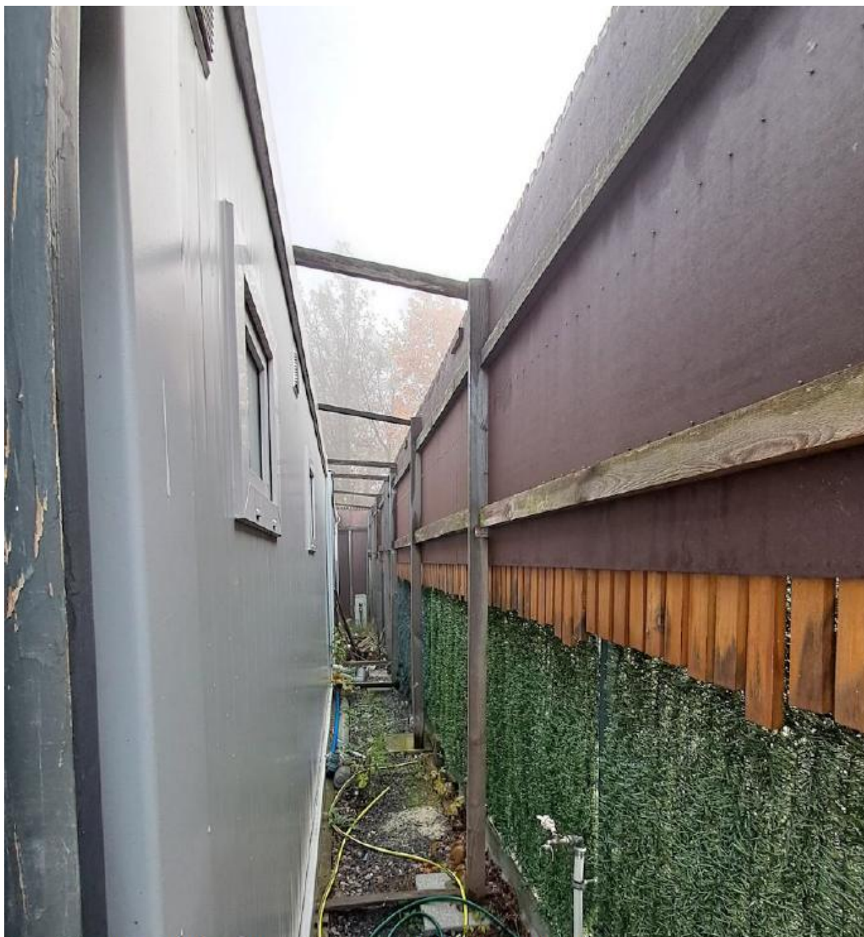
Rysunek 14 - istniejąca obudowa kontenerów sanitarnych do demontażu - widok tyłu
