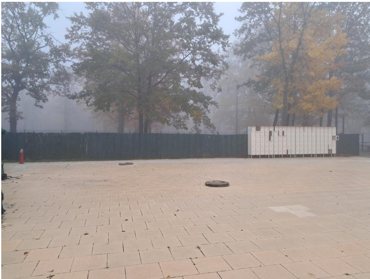
Rysunek 16 - widok istniejącego ogrodzenia panelowego do demontażu
