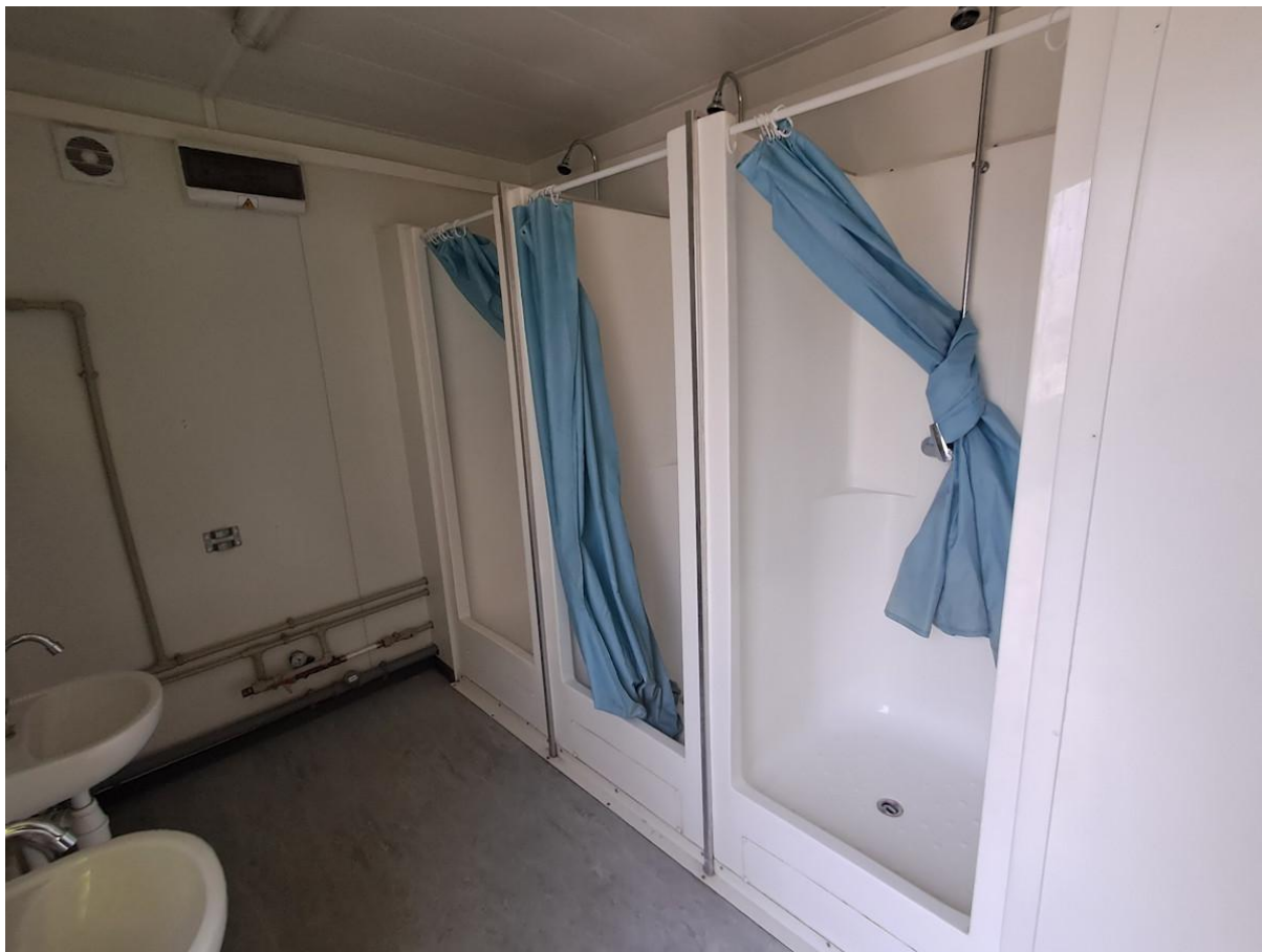
Rysunek 15 - widok kabin prysznicowych w istniejących kontenerach sanitarnych do demontażu
