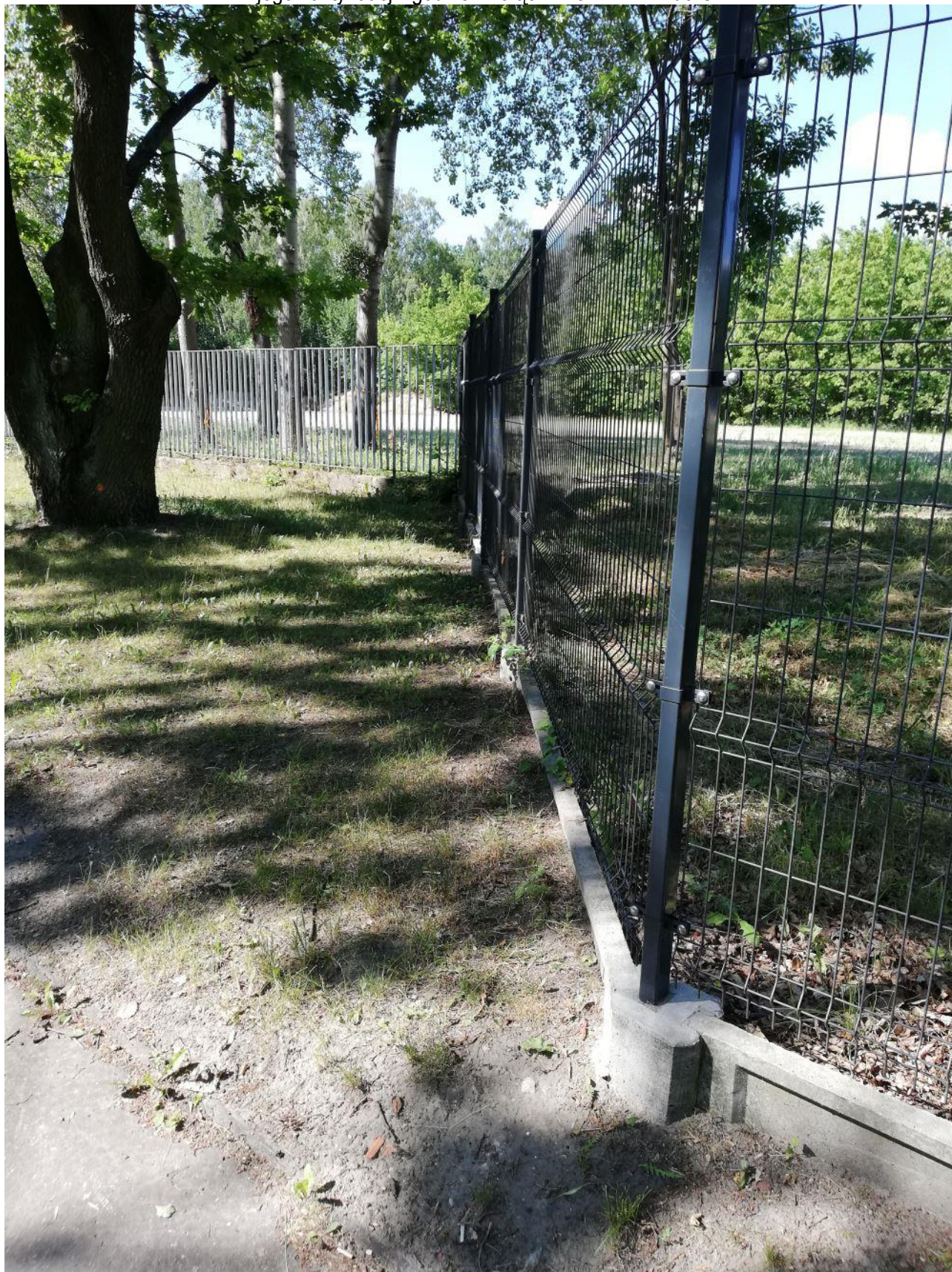
Rysunek 9 - demontaż obecnego ogrodzenia panelowego, systemowego na uskoku, na długości 10mb
