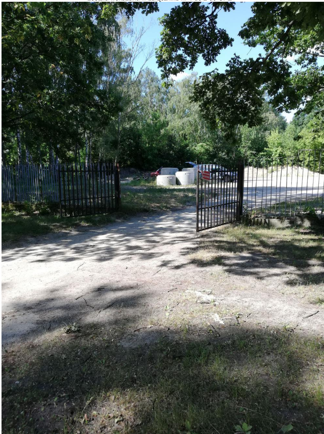
Rysunek 8 - metalowa brama podlegająca demontażowi i utylizacji
