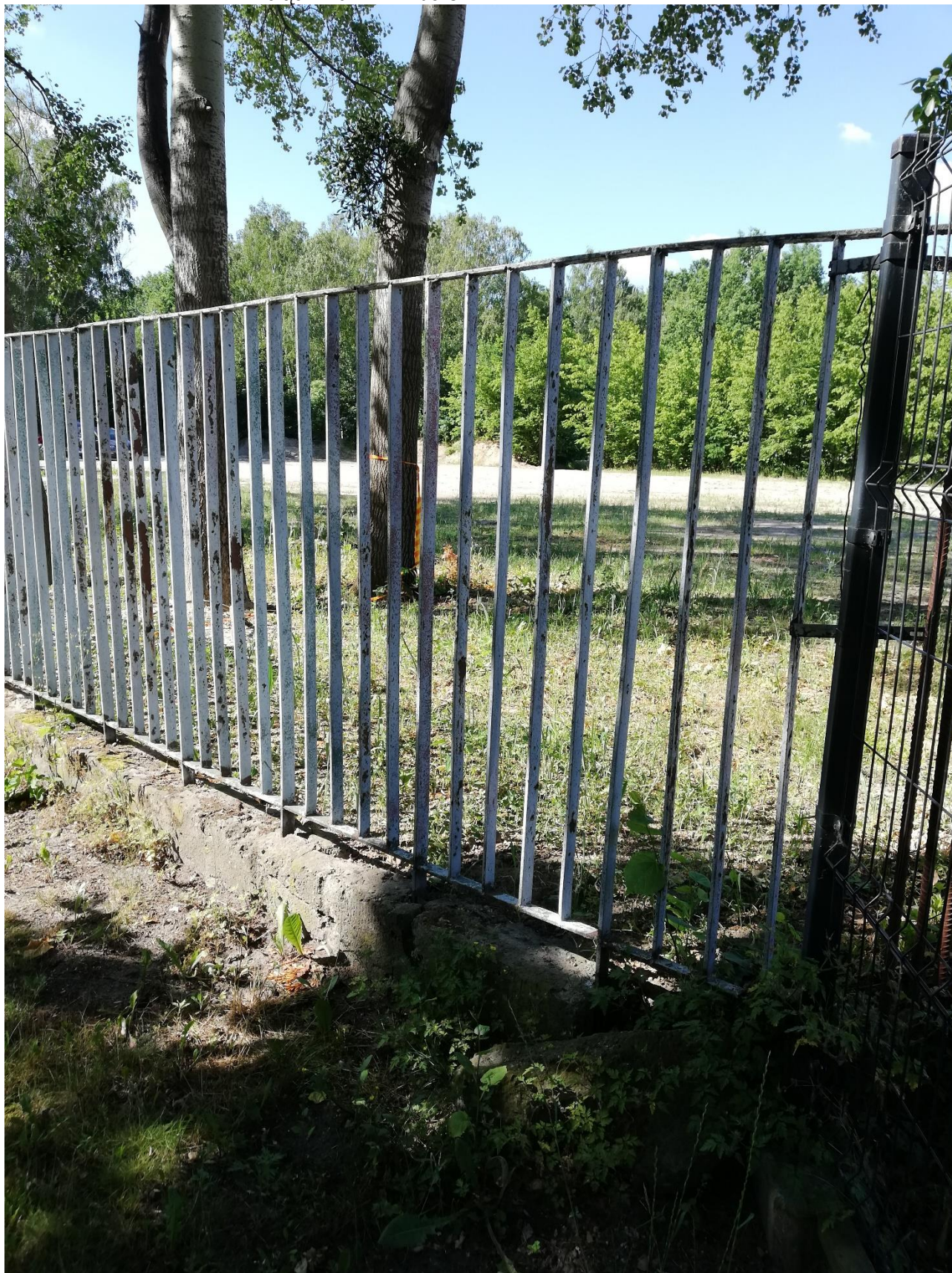
Rysunek 7 - metalowe ogrodzenie podlegające demontażowi
