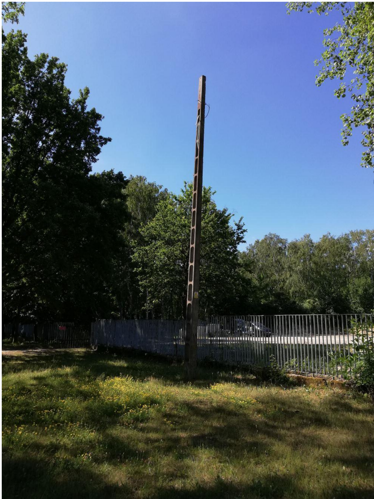
Rysunek 6 - nieczynny słup energetyczny od strony zewnętrznej nowo projektowanego parkingu
