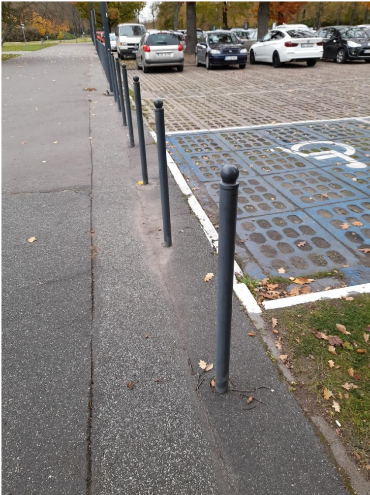
Rysunek 9 - słupki stalowe zamontowane na parkingu aquapark
