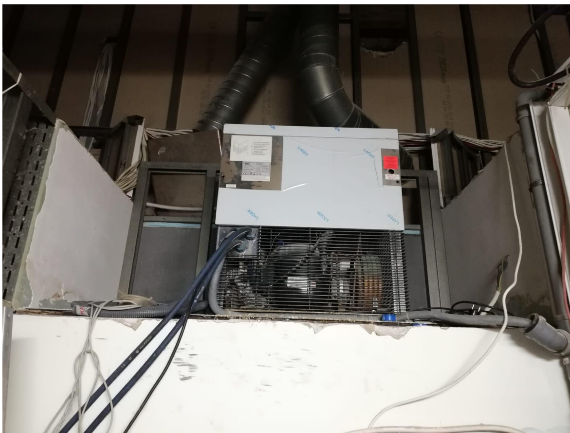
Rysunek 19 - ubytki w ścianie na górnej półce stanowiącej podstawę łuszkarki do lodu
