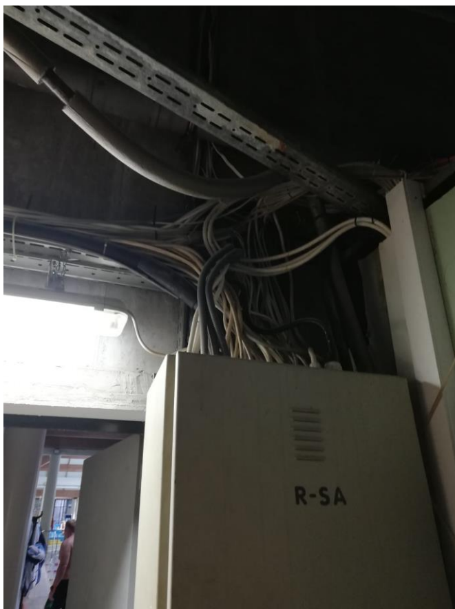
Rysunek 2 - rozdzielnia elektryczna R-SA – okablowanie
