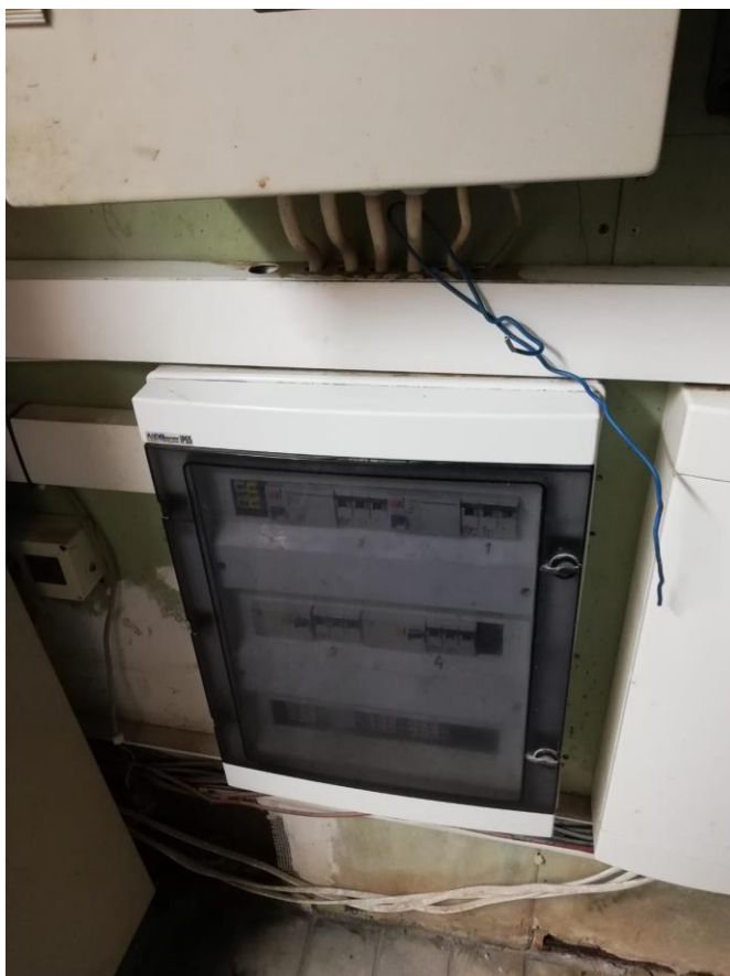
Rysunek 10 - rozdzielnia od generatorów pary do sauny parowej krystalicznej i parowej z chromoterapią
