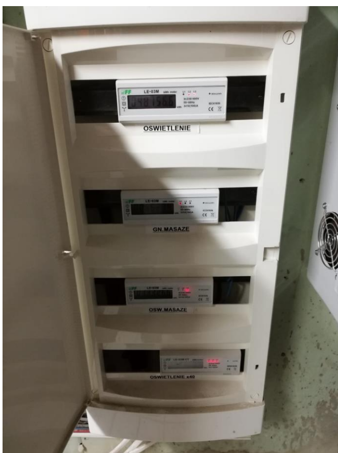
Rysunek 11 - opomiarowanie oświetlenia w Strefie Saun oraz Masaży
