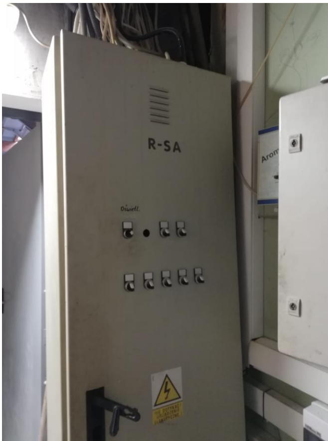
Rysunek 1 - rozdzielnia elektryczna R-SA widok z zewnątrz
