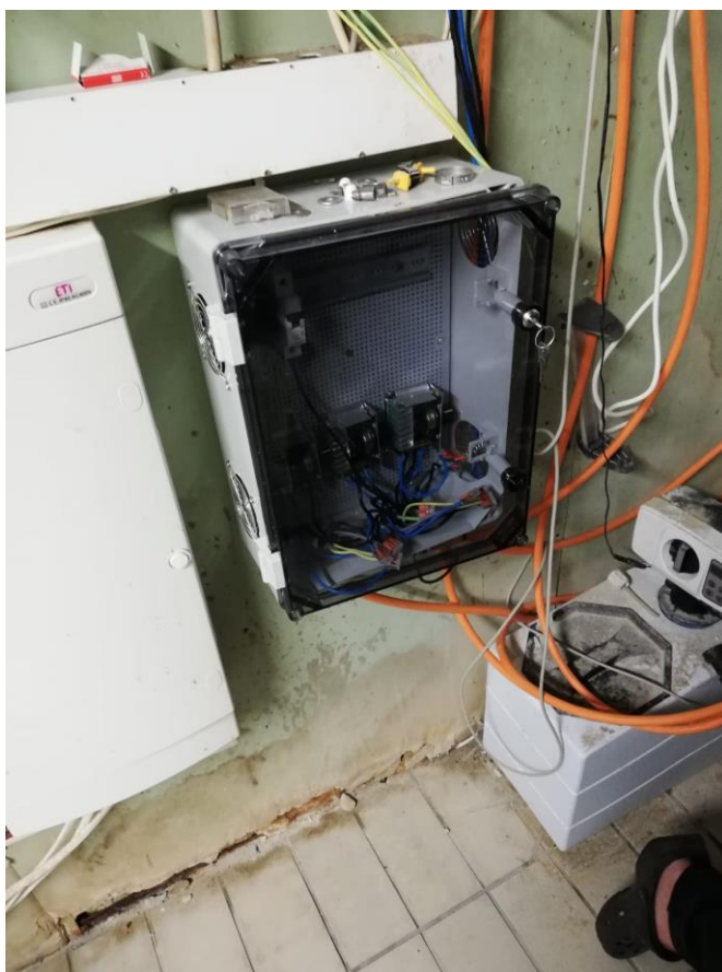
Rysunek 5 - sterowanie promiennikami podczerwi w saunie na podczerwień
