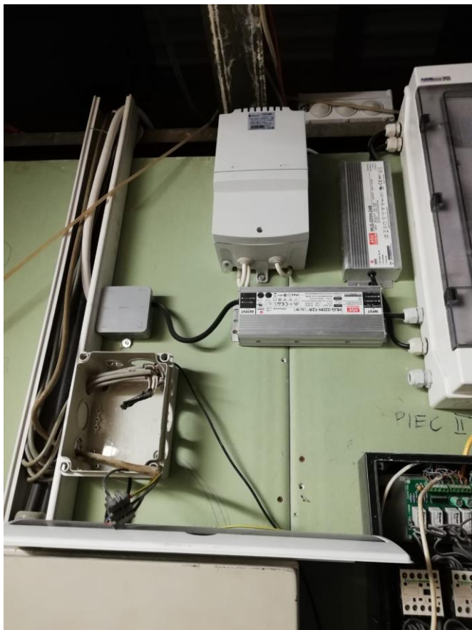
Rysunek 12 - zasilacze do oświetlenia LED
