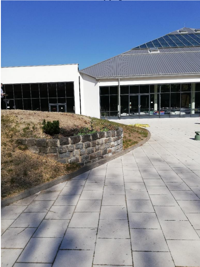
Rysunek 35 - istniejący murek na skarpie do demontażu
