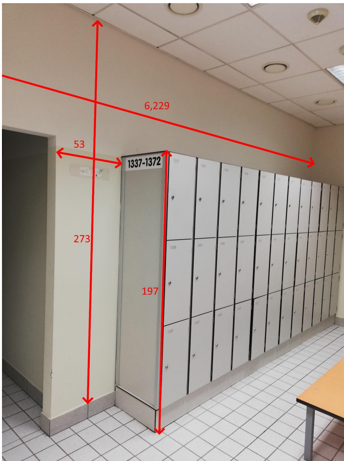
Rysunek 23 - szafki saunowe możliwe do odsunięcia od ścian
