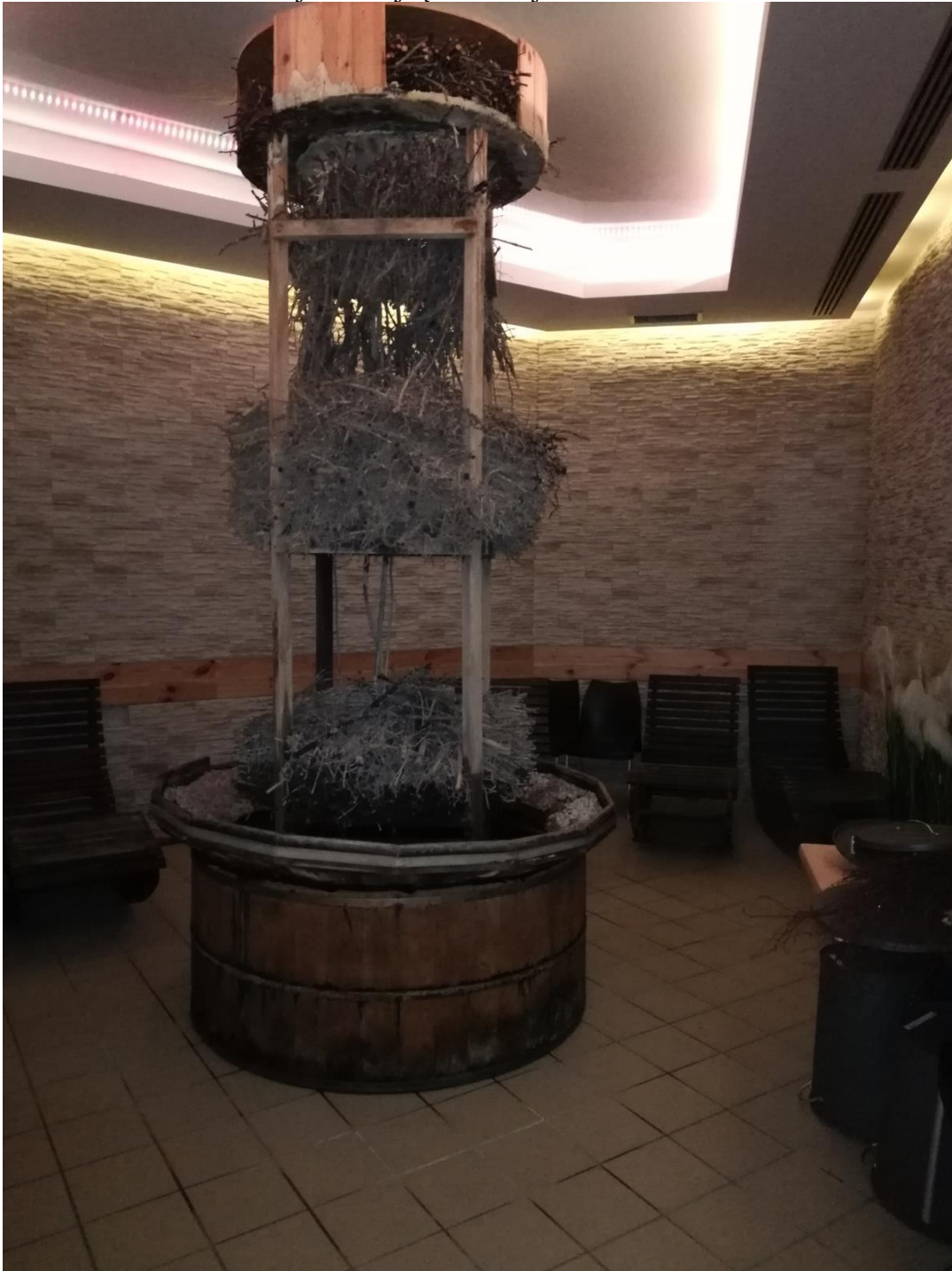
Rysunek 4 - konstrukcja tężni solnej
