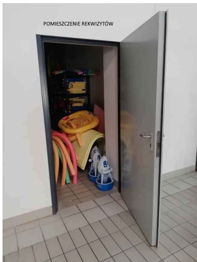
Rysunek 3 - drzwi p.poż. do demontażu
