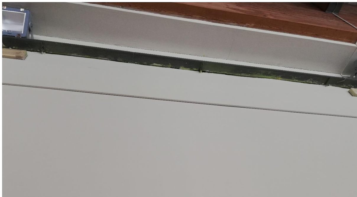
Rysunek 22 - malowanie koryta kablowego na kolor ściany
