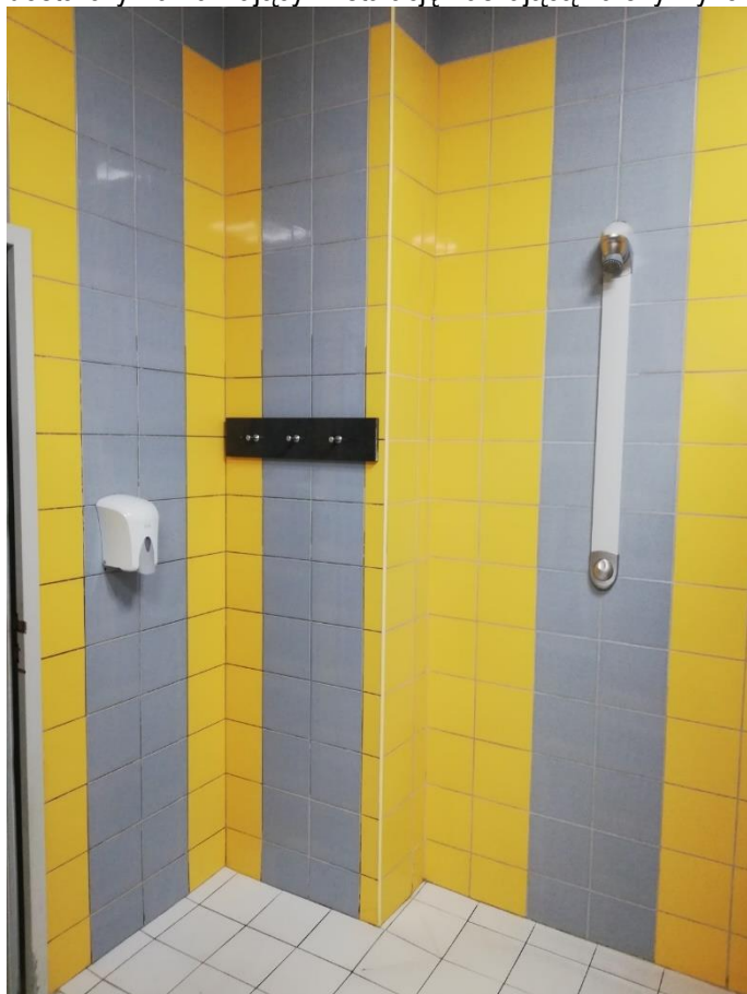
Rysunek 23 - natryski natynkowe PRESTO DL 400 SE dostarczone przez Zamawiającego
