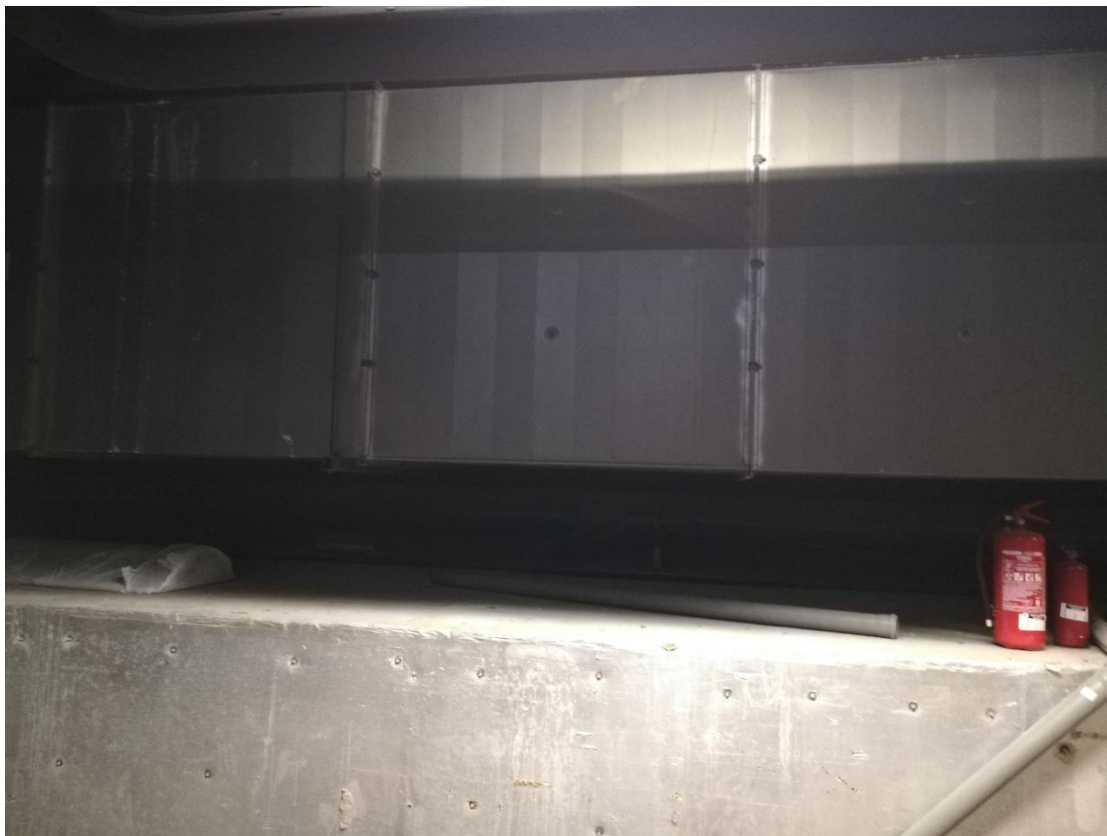
Rysunek 28 - widok miejsca przejścia z podbasenia instalacją zasilania do brodzików dezynfekcyjnych natrysków od strony basenu z falą / konieczność zdemontowania na czas prowadzenia robót metalowych kanałów wentylacyjnych
