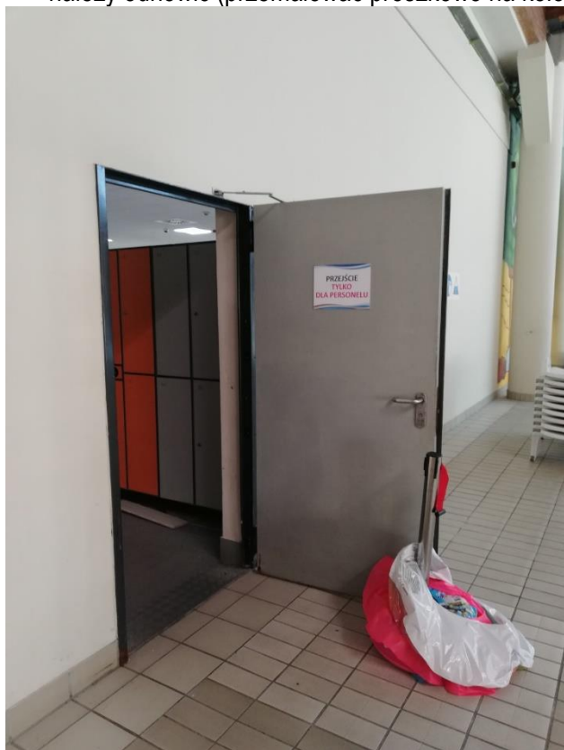
Rysunek 4 -drzwi p.poż do przeniesienia i przemaalowania
