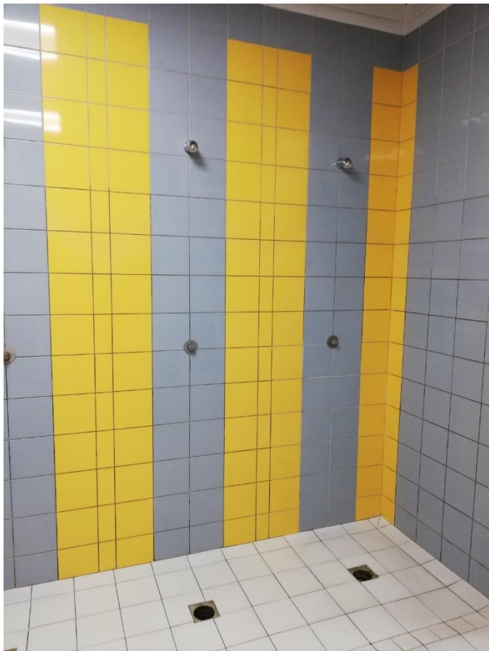
Rysunek 15 - przykładowa ściana wewnętrzna z płyt GK w natrysku męskim od strony basenu z falą
