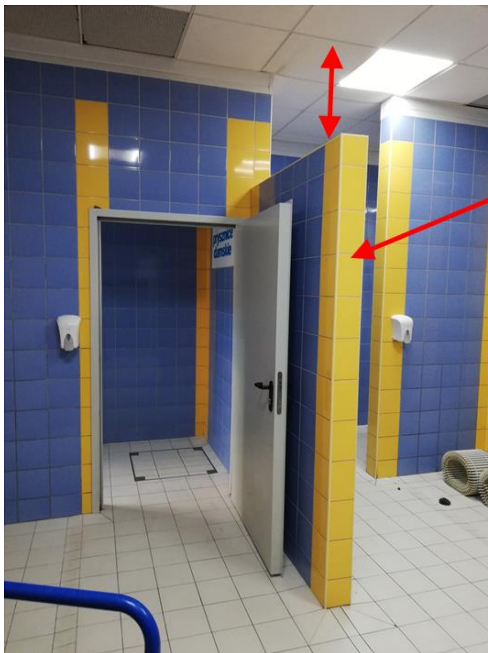
Rysunek 30 - wypełnienie wewnętrznych, środkowych ścian do samego sufitu
