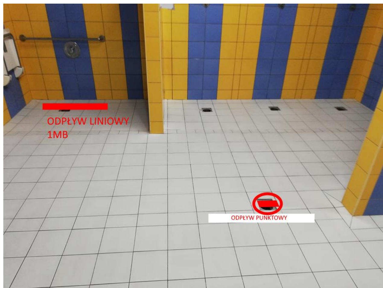
Rysunek 25 - odpływ liniowy pośrodku pomieszczenia natrysku oraz odpływ liniowy w natrysku dla osób niepełnosprawnych
