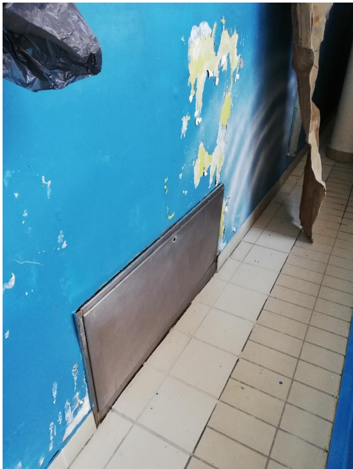
Rysunek 38 - pokrywa rozdzielacza ogrzewania podłogowego
