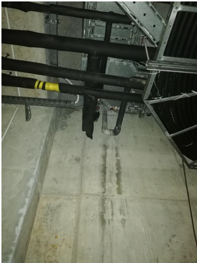
Rysunek 27 - widok podejścia zasilania do brodzików dezynfekcyjnych natrysków od strony basenu sportowego (podbasenie)
