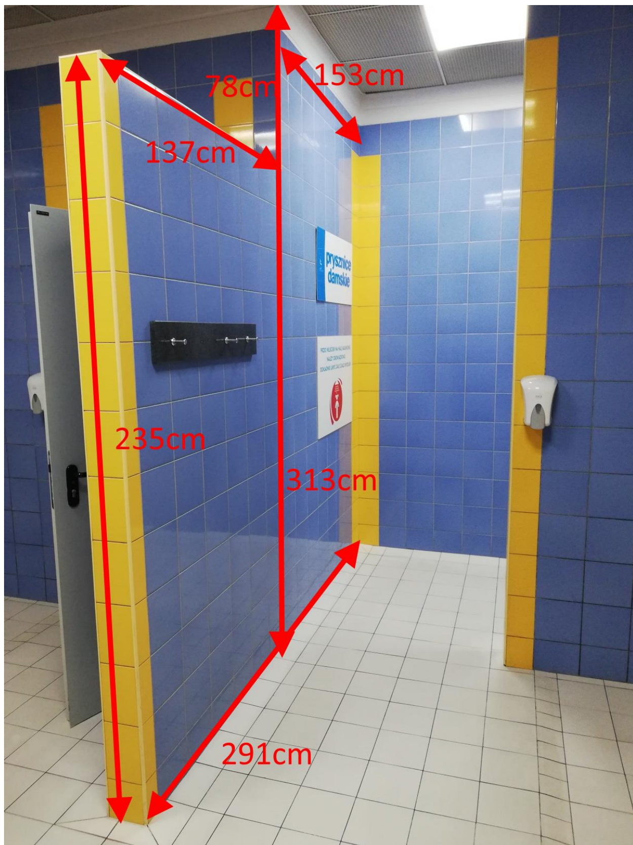
Rysunek 11 - wymiary ścianek wewnętrznych w natryskach
